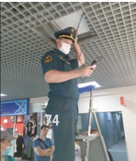
Июнь 2020 год. Проведение аэродинамических испытаний системы дымоудаления
