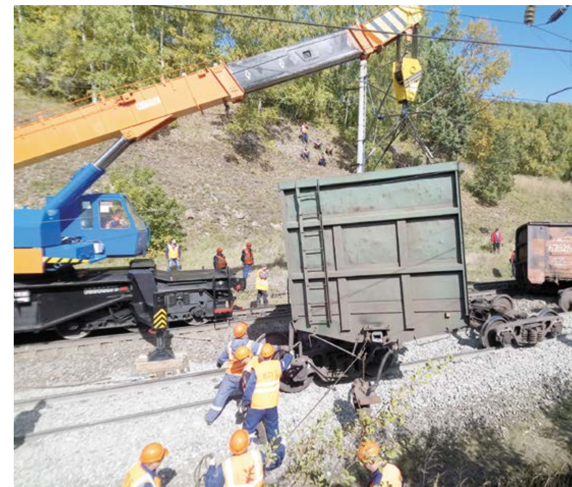
Сентябрь 2018 года. Устранение аварии на железной дороге
