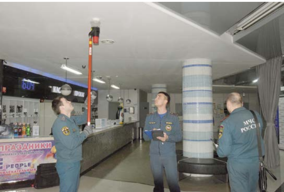
Апрель 2018 года. Проверка систем противопожарной защиты
